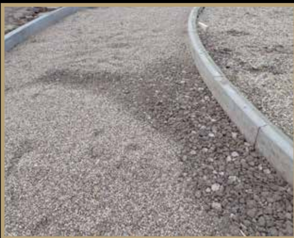
Drenážní vrstva z lámaného kamene
