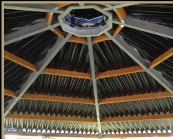
Lakovaná dřevěná vaznice
